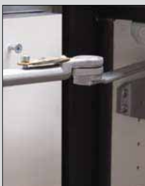
Dispositivo di arresto automatico HOF Hold open feature HOF
